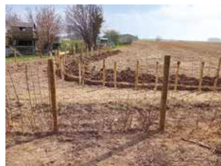
Fascine en coin de champ (sur la photo en cours de construction), doublée de plants de haie anti-érosion – Rue du Ruisseau Saint-Jean
