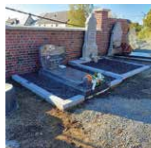
Reconstruction du mur d'enceinte
