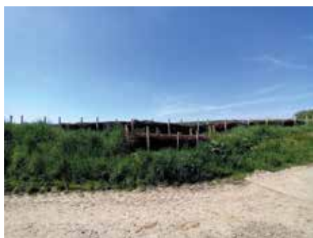
Fascines en bordure de champ et dans un talus – Carrefour rue des Champs / Rue des Fripiers
